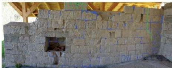
2022 - Elevation Nord du mur Nord du chœur - Projet - En bleu proposition de confortement par injection des joints et en vert les observations / injections proposées dans les pierres lésées.
